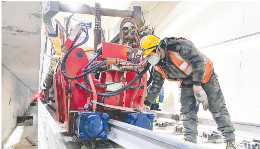
工人操作新能源焊轨机。
