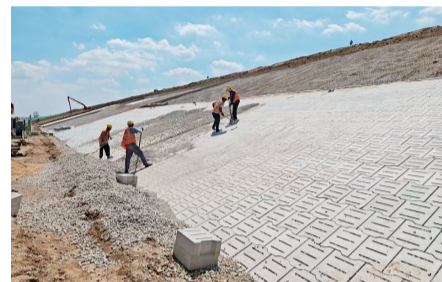
官路水库输配水工程施工现场。
