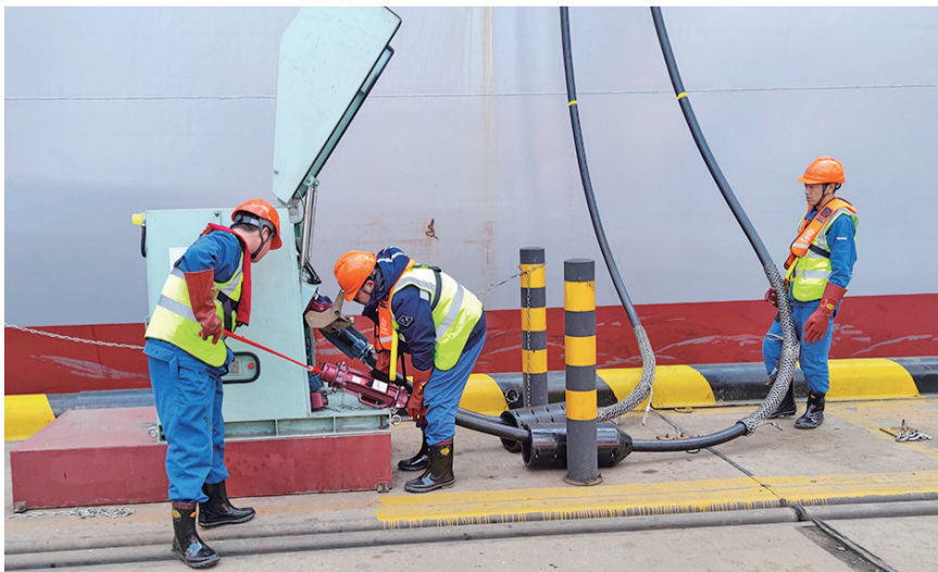
青岛港岸电数据平台上线试运行。
