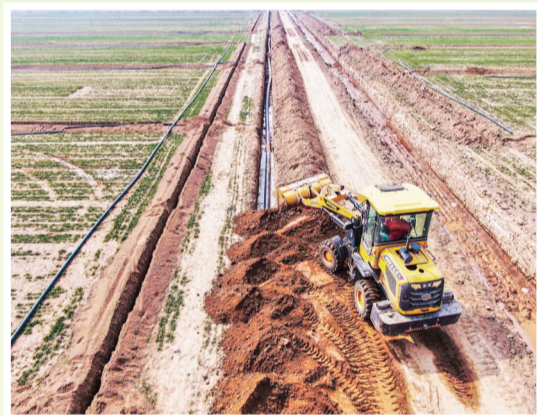
大场镇无人智慧农场智慧喷灌系统建设现场。
