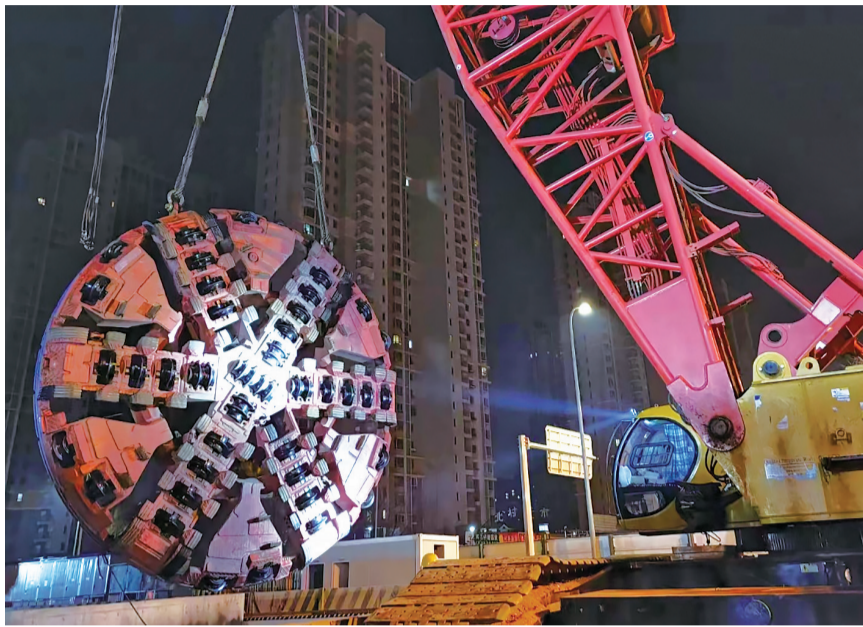
“开拓号”刀盘吊装入井。青岛地铁供图
