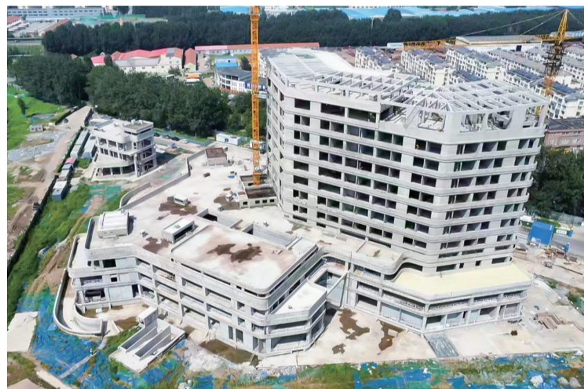
胶州市妇幼保健院新建项目进入主体装修阶段。
