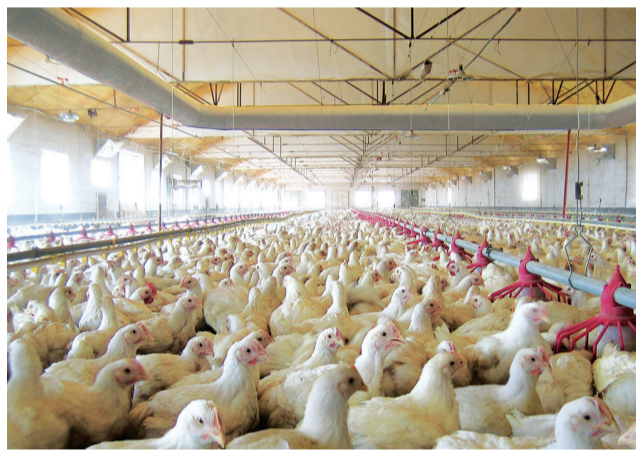
鸡舍里配备空调。
