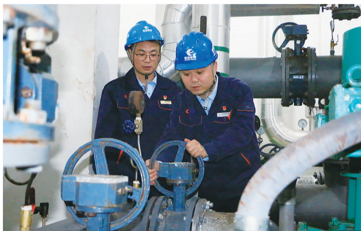
浮山后中心换热站工作人员对供热管网进行检修。
