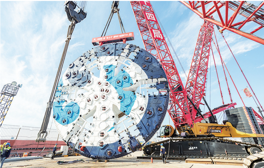
“海天号”盾构机600吨刀盘下井。施工单位供图
