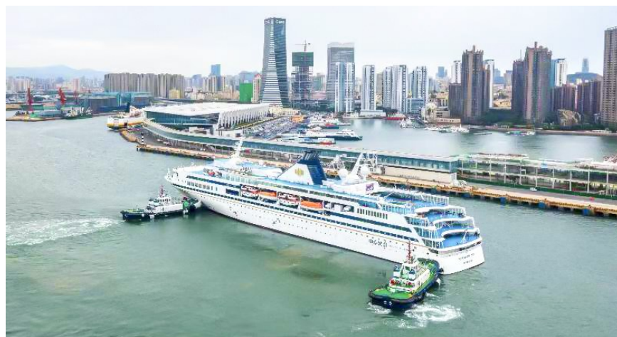
青岛港老港区邮轮码头改扩建工程竣工验收。 市交通运输局供图
