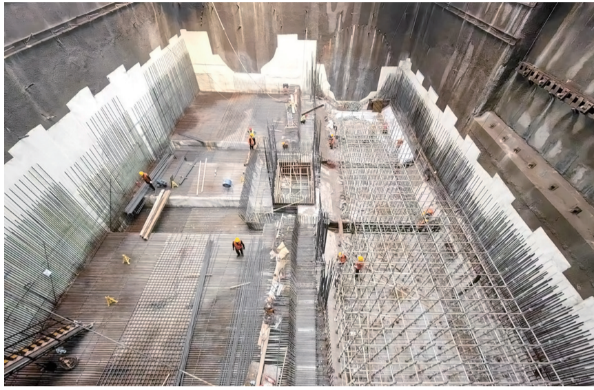
15号线下富区间始发井施工现场。 地铁供图
