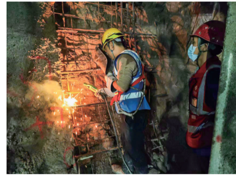
15号线下富区间的施工人员。 地铁供图
