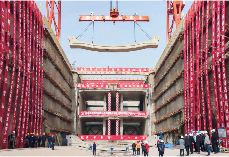
地铁底板吊装。
