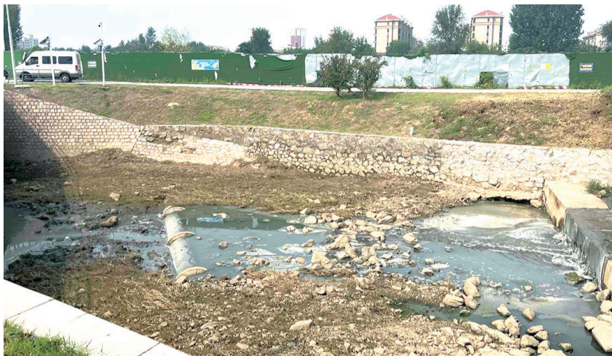
庞家沟岔村西侧河流里满是漂浮物与垃圾。
