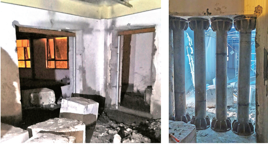
图左为网点房内被砸挖出洞口的剪力墙面。图右为临时加固装置。市民供图
