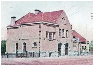
大港火车站建筑局部。
