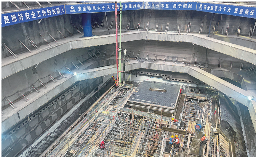
下富区间始发井主体结构施工现场。青岛地铁供图
