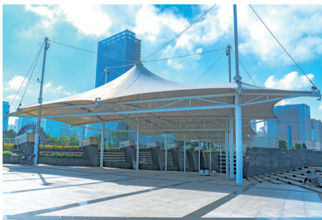
井冈山路地下通道出入口。
