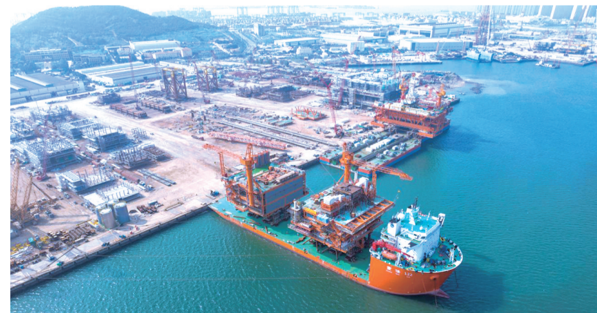
陆丰8-1平台生产模块、生活楼模块开始海上安装和联合调试。企业供图
