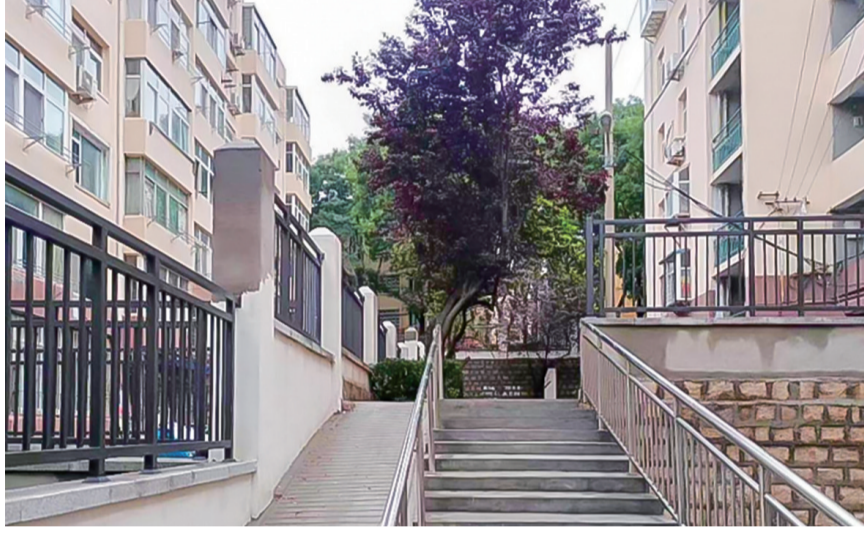
楼梯旁增加斜坡通道,方便社区坐轮椅的老年人通行。
