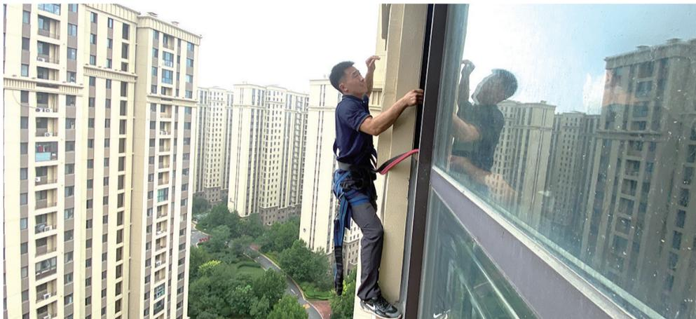
作为海尔空调安装工程师张书强的搭档,费金伟在19层楼高的外墙安装空调室外机。
