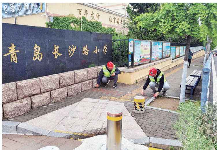
长沙路小学门口人行道已整修。
