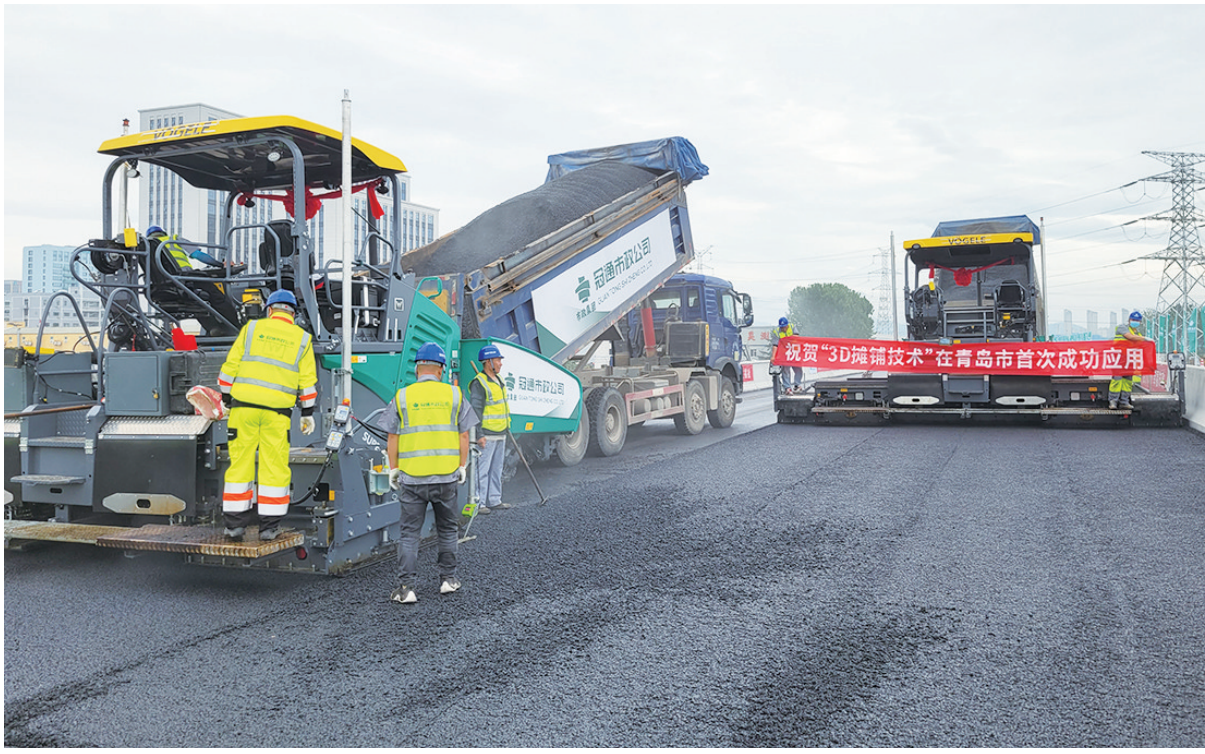
3D智能打印技术铺设路面,效率更好误差更小。观海新闻/青报全媒体记者 梁超 摄
