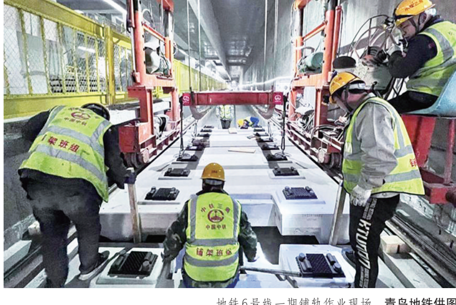
地铁6号线一期铺轨作业现场。青岛地铁供图
