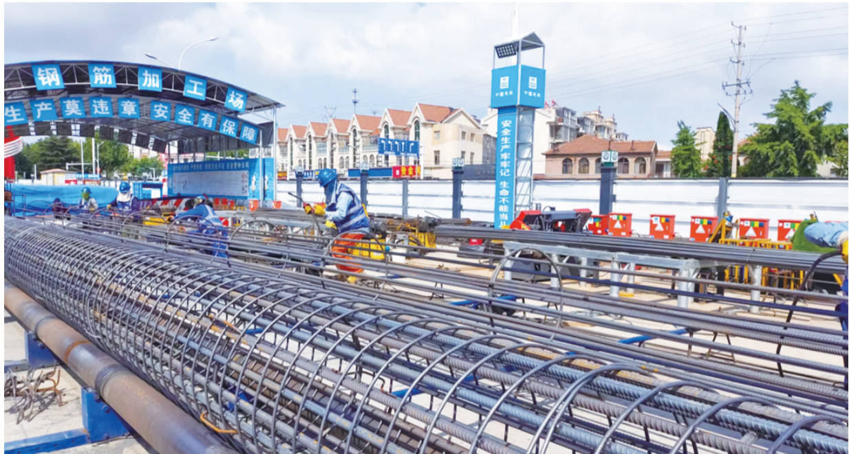
青岛地铁7号线文峰路站钢筋笼加工制作。
