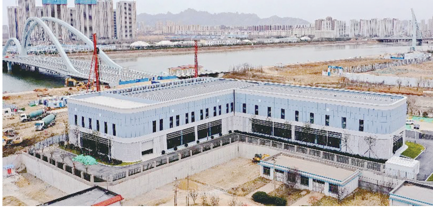
华能董家口电厂长输热力管线项目海洋活力区换热站。西海岸新区供图
