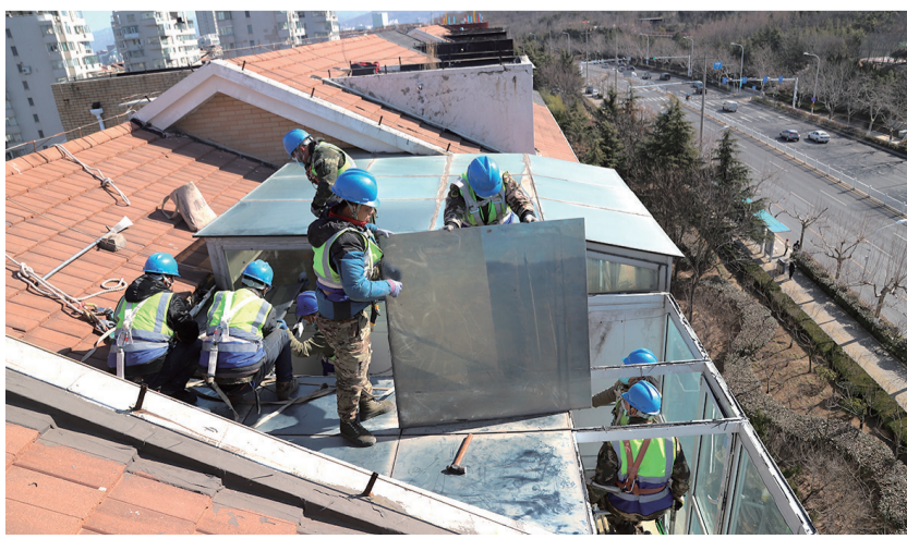
工人正在拆除鲁信长春花园小区违建阳光房。
