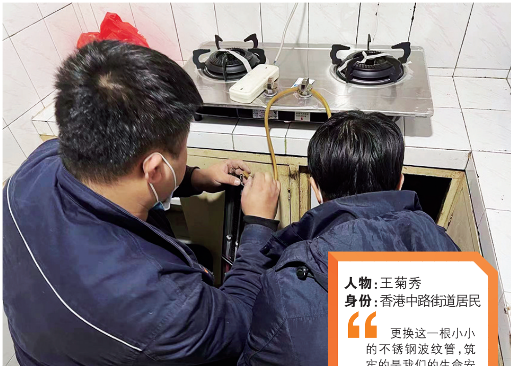
施工人员在为居民免费安装不锈钢波纹管。市城管局供图
