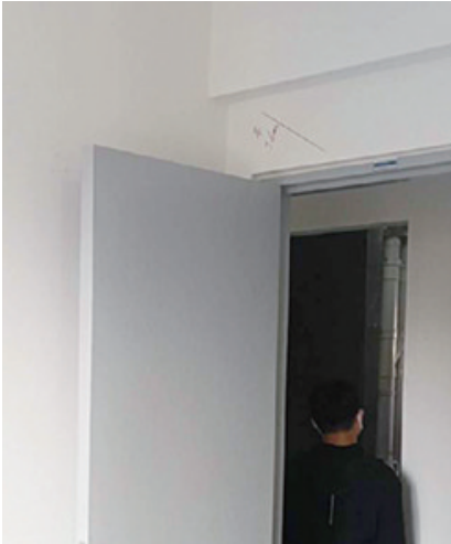
门洞上方墙面平整度有误。
