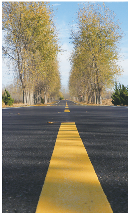
整修一新的山东头至田横码头路。
