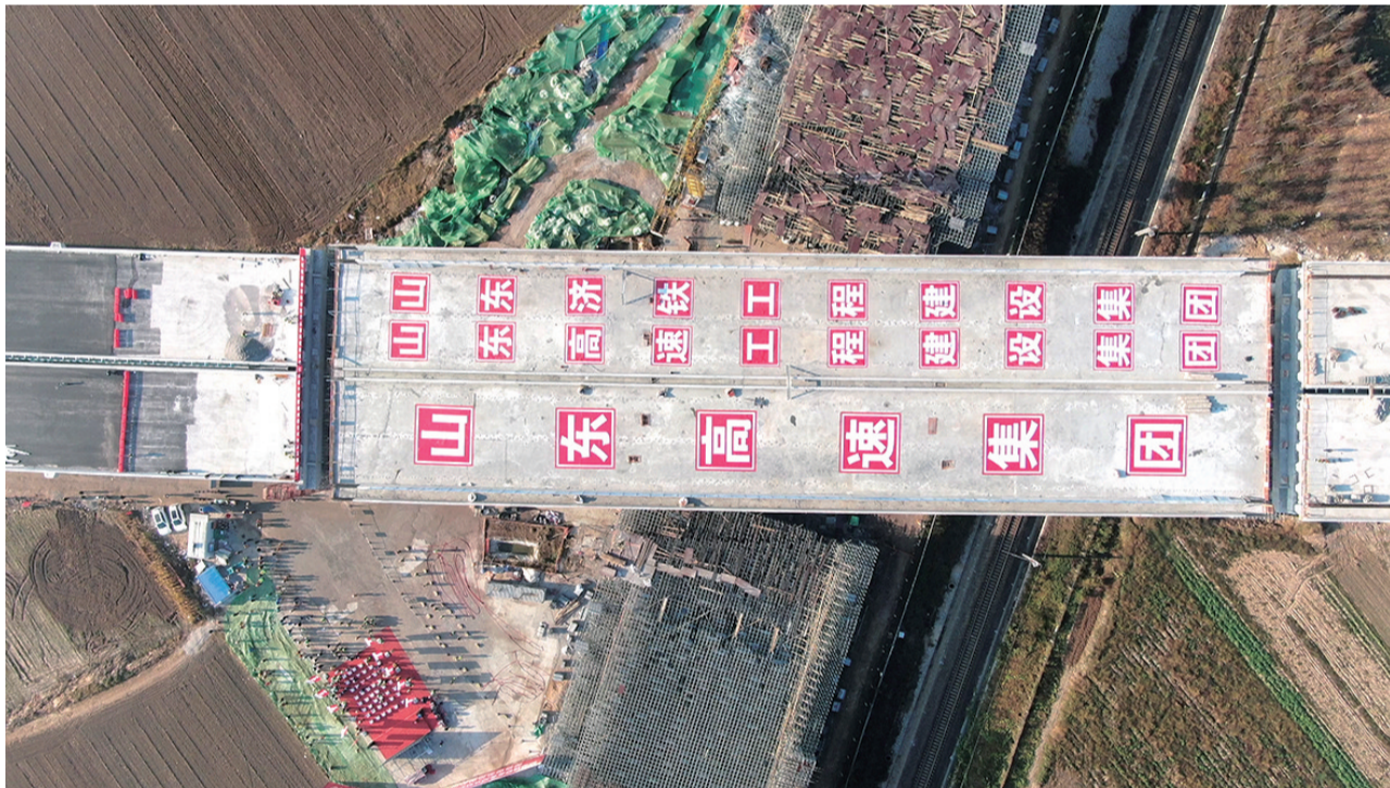
济青中线跨胶新铁路转体桥完成转体。建设方供图
