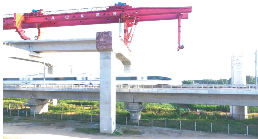
潍烟铁路项目昌平特大桥上跨潍荣高铁营业线Ⅱ级运架梁施工顺利完成。
