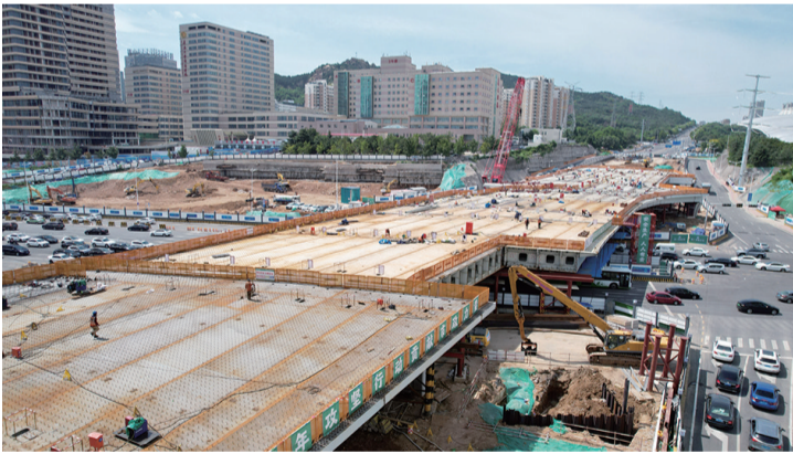
航拍海尔路—银川路立交工程施工现场。
