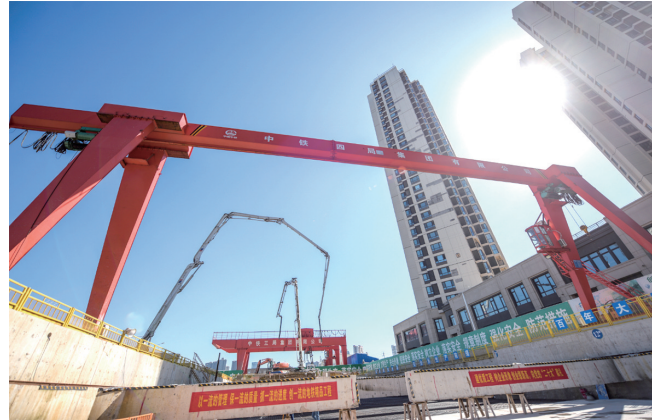
地铁2号线西延段施工现场。
