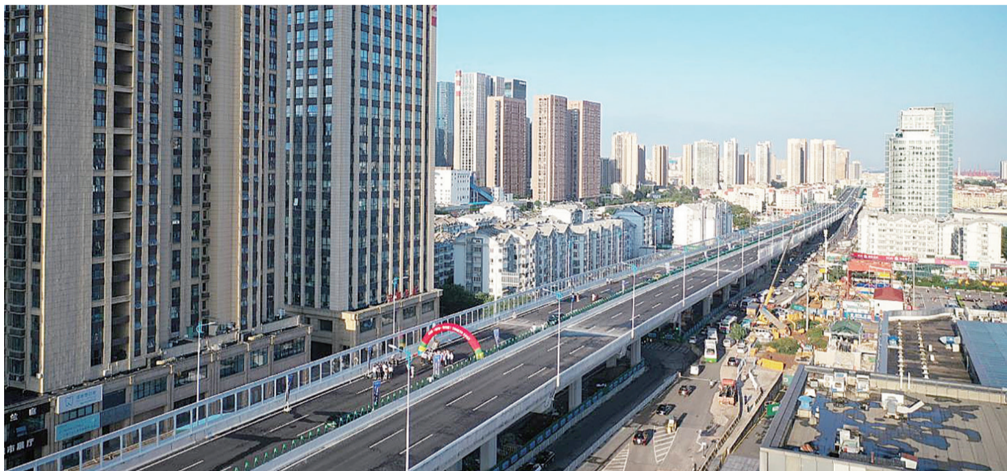
辽阳路(南京路至福州路段)交通结建工程主线桥昨晨通车。
