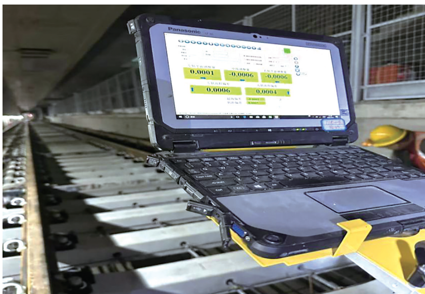
CP III轨道精测小车指导钢轨精调作业。
