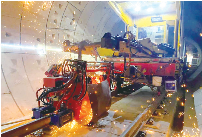
青岛地铁2号线二期全线轨通。
