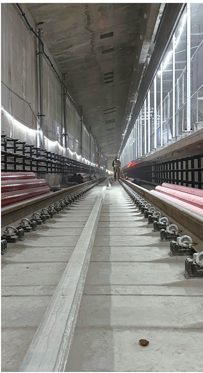
青岛地铁2号线二期内景。
