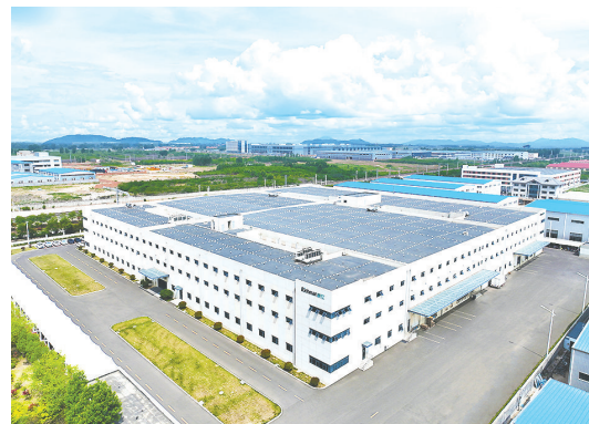
青岛豪江智能科技股份有限公司坐落于即墨区青岛科技创新园。即墨区供图
