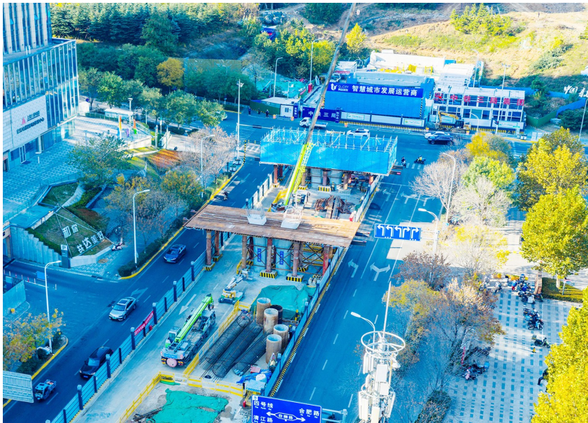
双山隧道及南延配套工程迎来新进展，项目建设全面加速。城发集团供图
