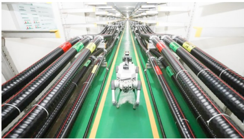
国网青岛供电公司应用机器人对重要区段220千伏电缆隧道开展智能巡检。
