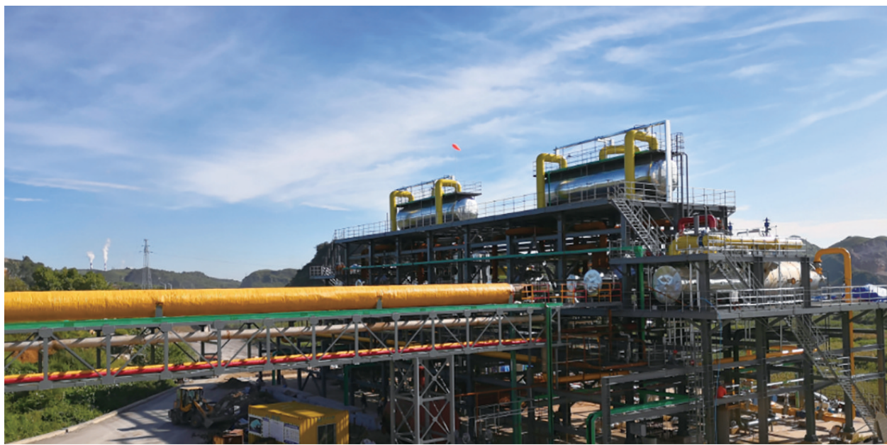
贵州红星发展股份有限公司厂区。
