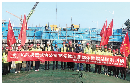
地铁15号线体育馆站主体结构封顶。
