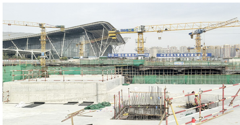
位于北站东广场附近的TOD项目正在加紧建设。 刘卓毅 摄
