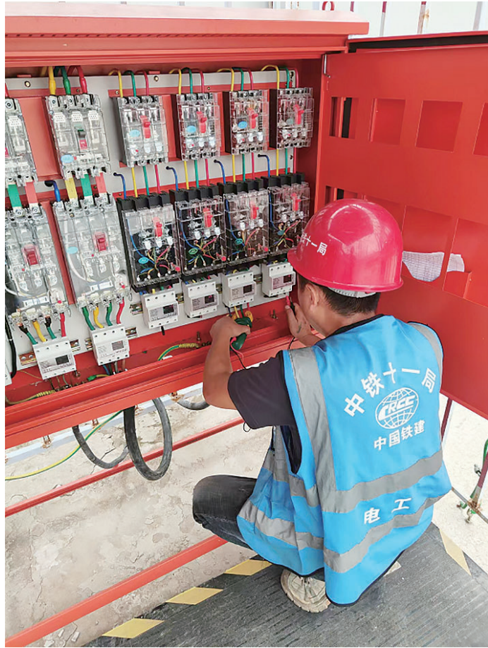
电工现场测试电压电流。
