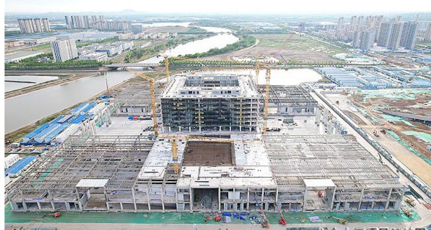
确认，保障工厂顺利加工及现场高精度拼装。主楼中空区屋盖钢桁架重量160吨、跨度35米，经多方案比选研究，采取整体提升施工工艺进行施工。裙楼钢结构最大跨度54米，单榀自重达65吨，使用600吨大型履带吊进行场外吊装作业。在施工中技术人员全程跟踪，为钢结构高效作业保驾护航，并形成中空区钢结构采用整体提升、大跨度桁架履带吊场外吊装、大跨度钢桁架结构补偿变形施工等多项先进施工技术。
