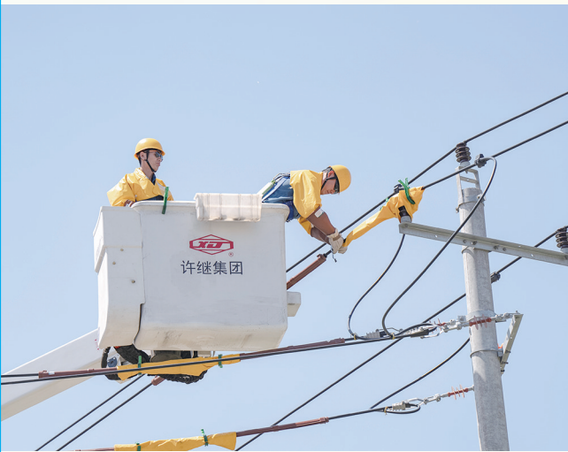
国网青岛供电公司积极开展带电作业,全力保障客户可靠用电。
