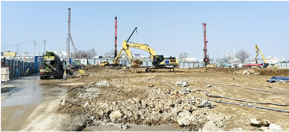
项目施工现场正在打桩。 刘卓毅 摄
