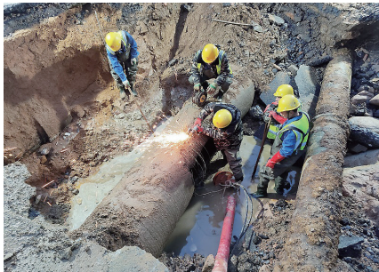
抢修人员紧急抢修爆裂的自来水管。
