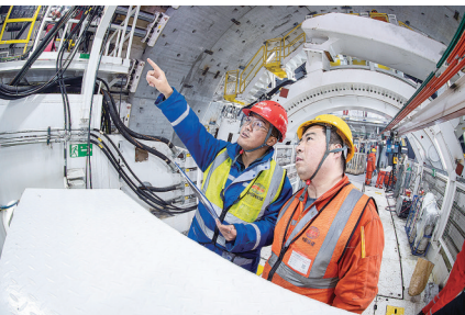
施工人员正在查看盾构机掘进情况。
