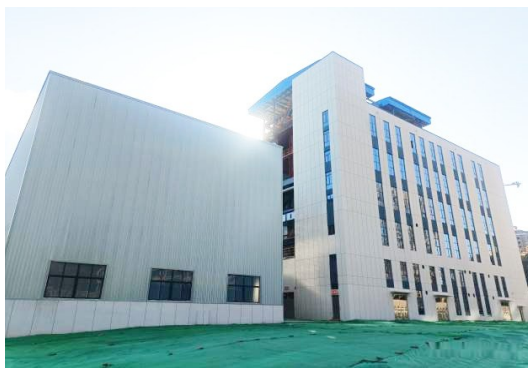
家盛热力高效集中供暖工程。
