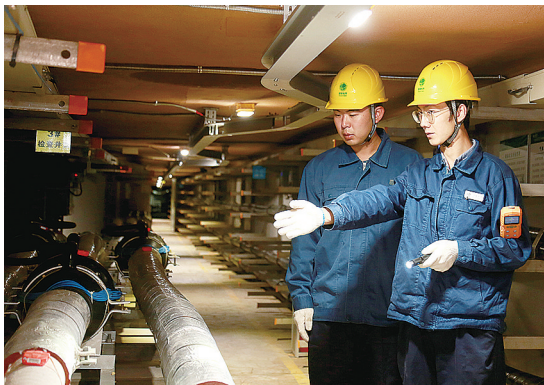
青岛供电公司工作人员对220千伏延吉路电缆隧道进行测温巡视,保障青岛电网安全稳定运行。
