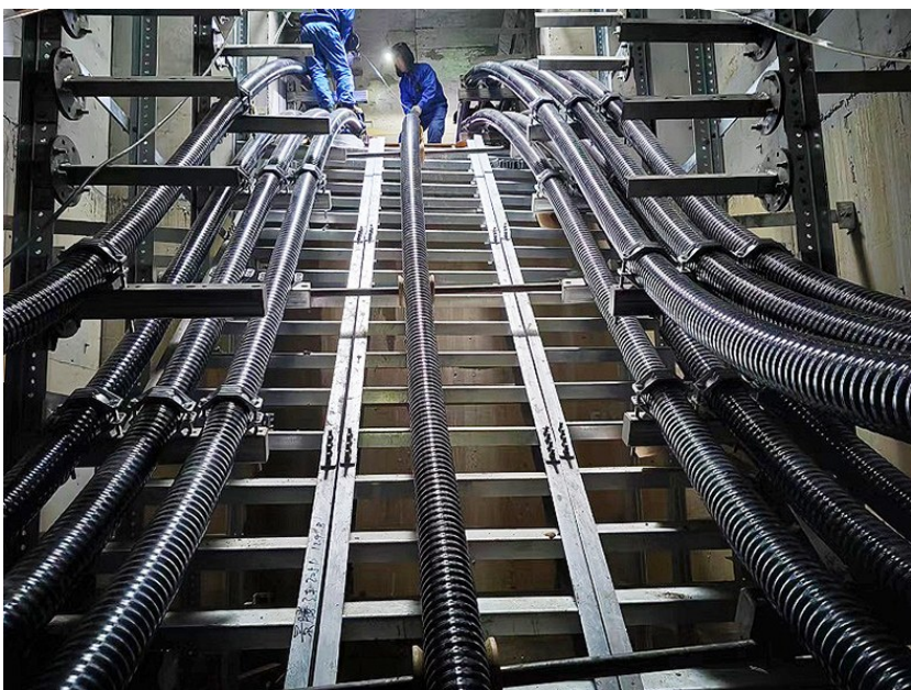
重 庆 路 周 边 地 下 管 廊 工 程 完 成 电 缆 下 地 入 廊 施 工。
